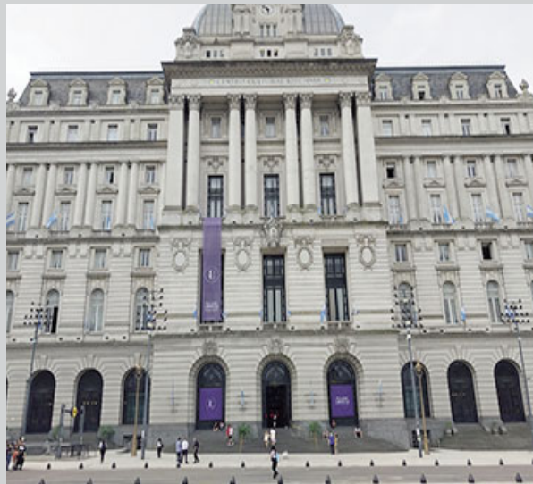
Fachada actual del rebautizado Palacio Libertad.
